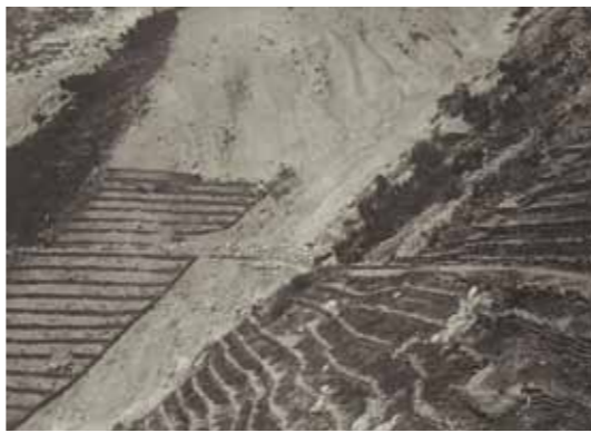
Consolidamento dei versanti con viminate e gradinate - Archivio fam. Borghetti
