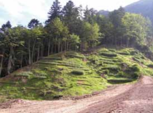
Intervento recente di consolidamento dei versanti - S. Mazzucco
